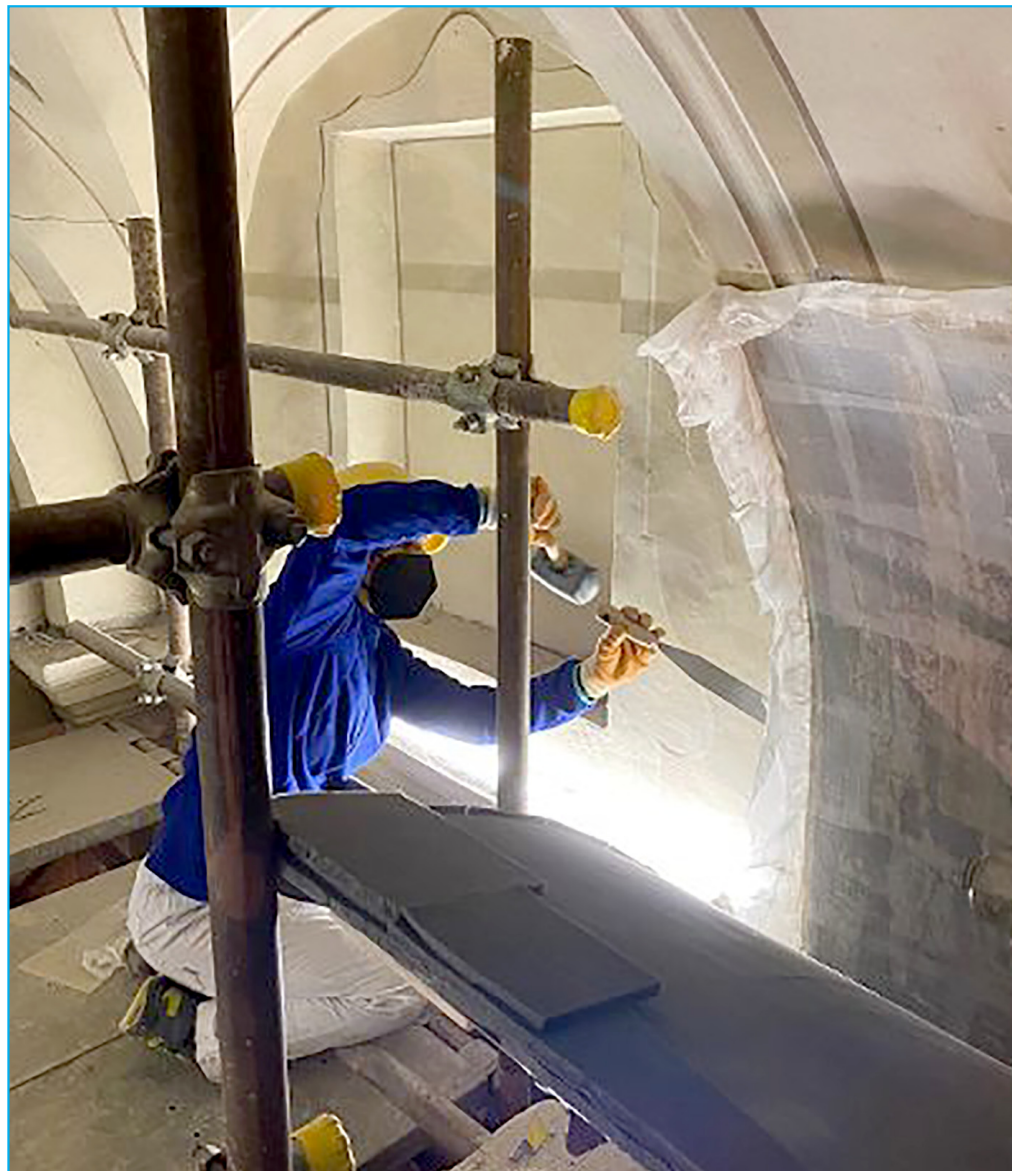
Distacco del prezioso frammento dell'antico trompe l'oeil architettonico per lo studio e la conservazione
