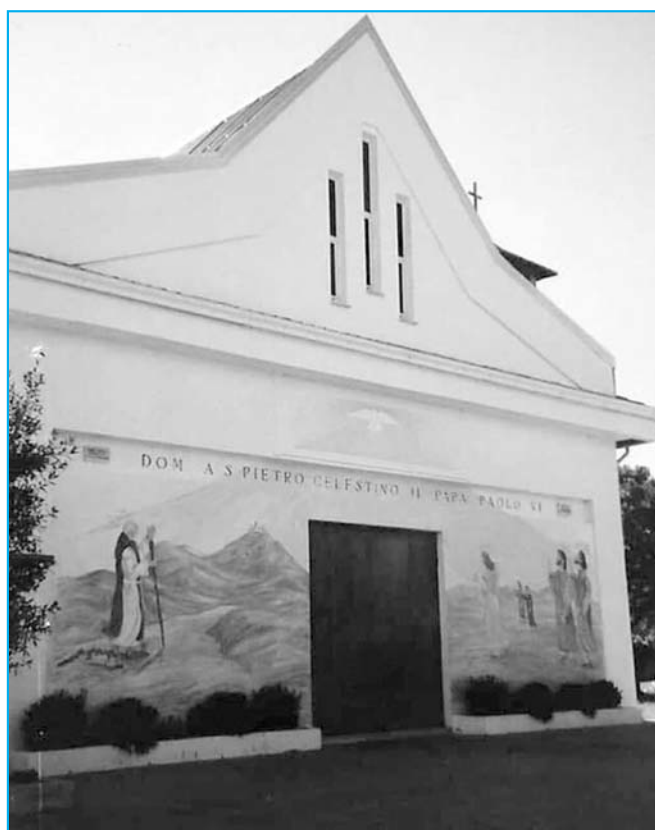
La facciata della chiesa, dipinta nel 2001.
